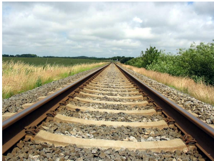
FIGURE 1 – les rails sont parallèles
